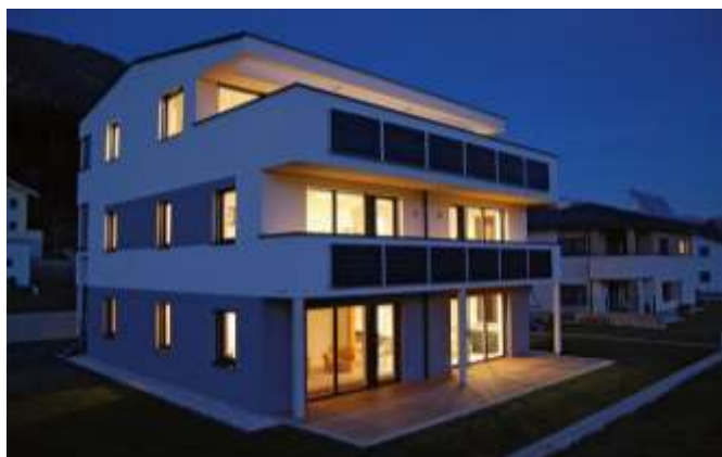
Il primo edificio generazionale si trova a Pusarnitz ed è stato realizzato con una costruzione intelligente a telaio e con X-lam. ©heutemorgen
