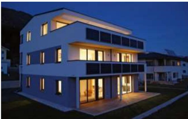
Das erste Generationengebäude steht in Pusarnitz und wurde mit einem intelligenten Holzriegel und Brettsperrholz ausgeführt ©heutemorgen
